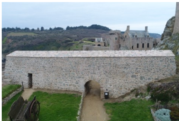
Le gros mur (Parados)
